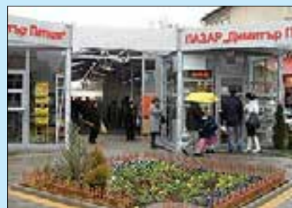
Строителен надзор на Реконструкцията на „Пазар „Димитър Петков“
