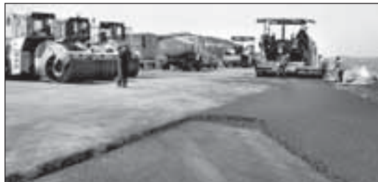
Министърът на регионалното развитие и благоустройството Лиляна Павлова и председателят на УС на Пътна инфраструктура инж. Лазар Лазаров проверяват строителните работи на автомагистрала Тракия при пътен възел Ямбол. снимка: БТА
